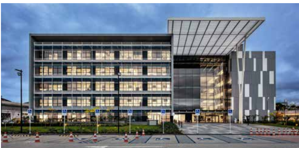
Sede do escritório e edifício anexo em Vila Velha/ES.
